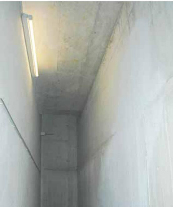
oben: Der Blick in den mehr als 90 Meter langen Erdkanal zur Klimatisierung der Schweinfurter Büroräume mittels Erdwärme und -kühle.
